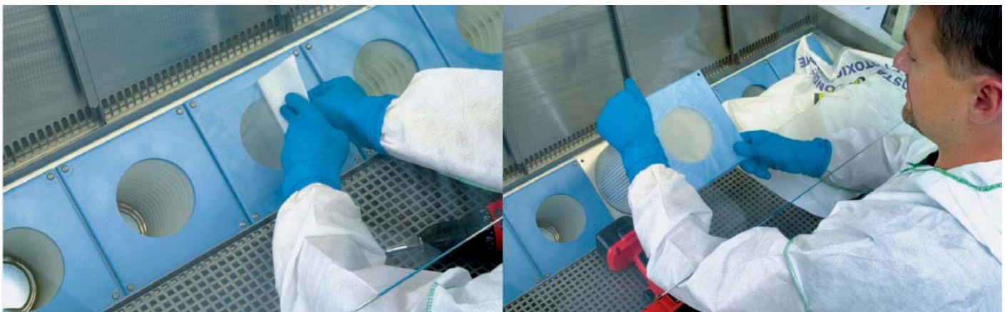
▼ Abb. 2: Aerosoldichtes Versiegeln und kontaminationsarmer Wechsel eines HEPA-Patronenfilters.
